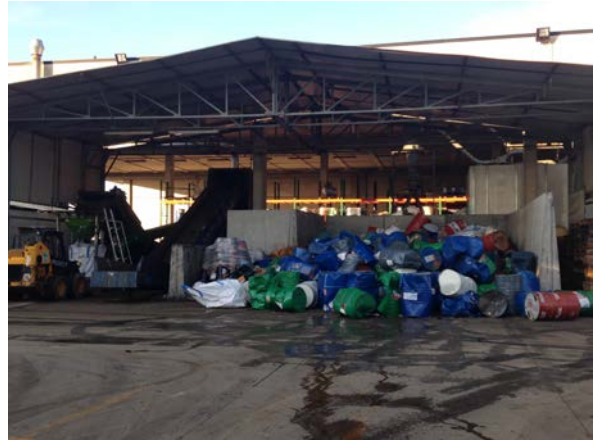
Dettaglio aree installazione
